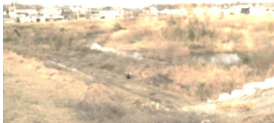
＜改修工事の進む真美ヶ丘池＞
